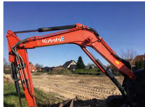
Baufeldräumung "Wohnen am Flaar"
