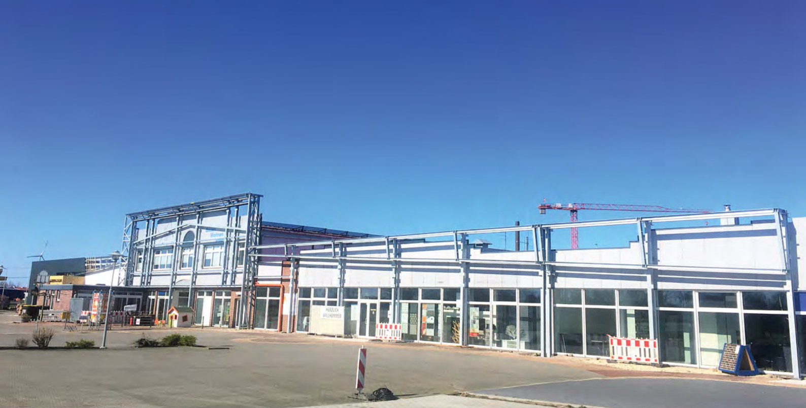
Die Erneuerung der Außenfassade hat begonnen
