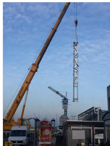
Kran zum Aufbau der Außenfassade
