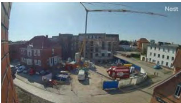
Baustellenkamera: Villa Harms
