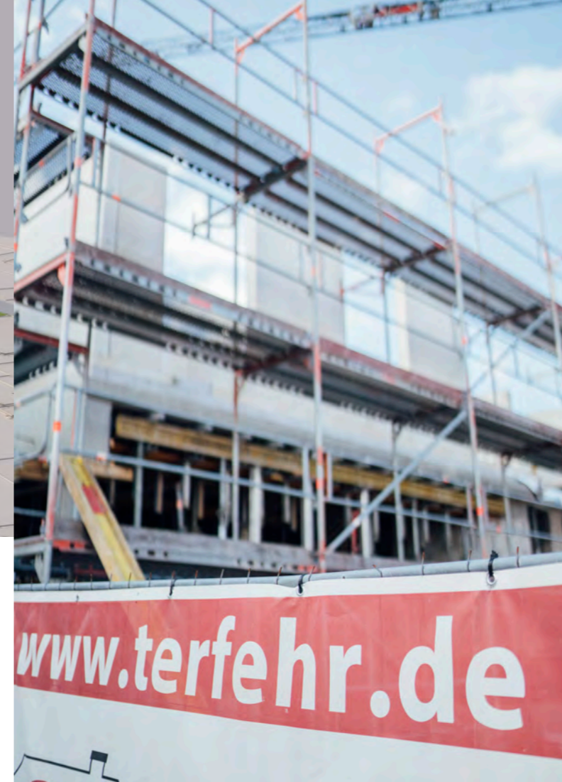
Blick auf die Baustelle
