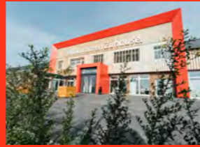
Titelbild: Eingang der neuen Bauwelt im Ems-Dollart-Zentrum
