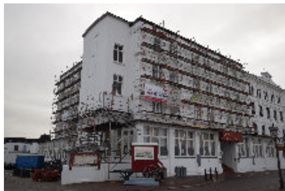
Erneuerung der Außenfassade
