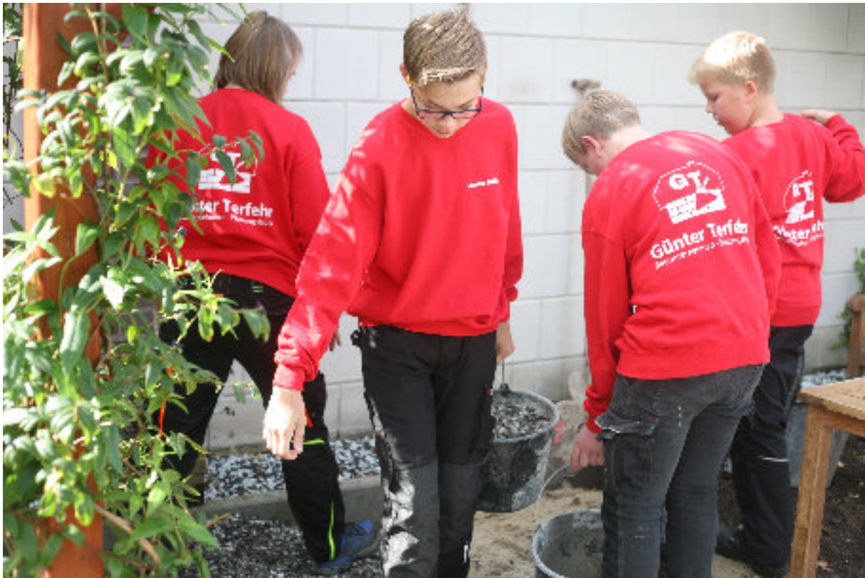
Mit vereinten Kräften wird an der Fertigstellung des Wasserlaufs gearbeitet
