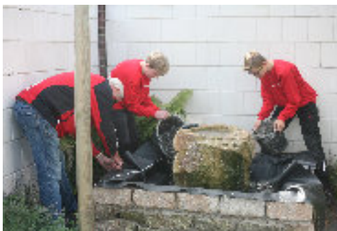
Der Wasserlauf wird mit Kies gefüllt
